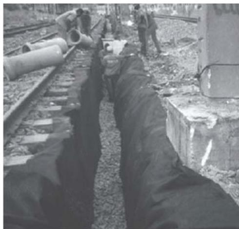
Figura 1. Dreno ao longo de uma ferrovia utilizando geotêxtil como elemento filtrante<sup>[5]</sup>.
