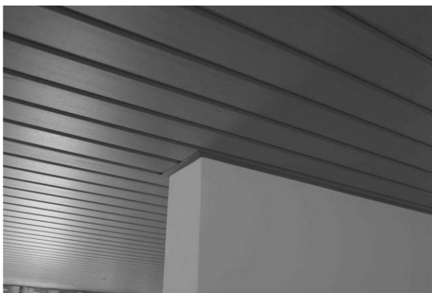
Figura 6. Exemplos de aplicação de compostos PVC/farina de madeira na fabricação de forros ( WoodCell ® Araforros)
